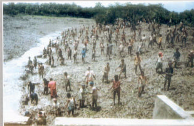
ভবদহ প্রাইস গেটের নিচের অংশে শ্রী নদীতে প্রকল্প কর্তৃক পলি অপসারণের কার্যক্রম, ১৯৯৭
